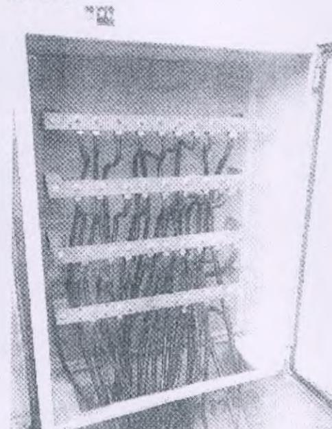
g) Entrada de Energia (Posto de Transformação) – foi efetuada a limpeza com aplicação de líquido específico para contatos elétricos, no disjuntor Geral de 225 Amperes;
